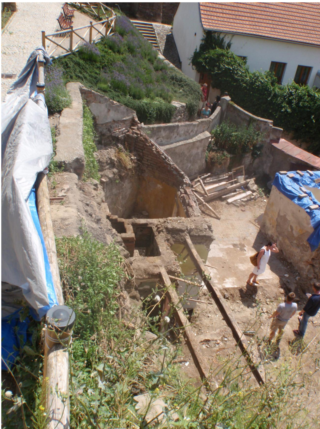
Příčné stěny RD jsou této fázi provizorního vzepření stěny zatím ponechány, jelikož příznivě vzpírají těleso posuzované opěrné stěny.
