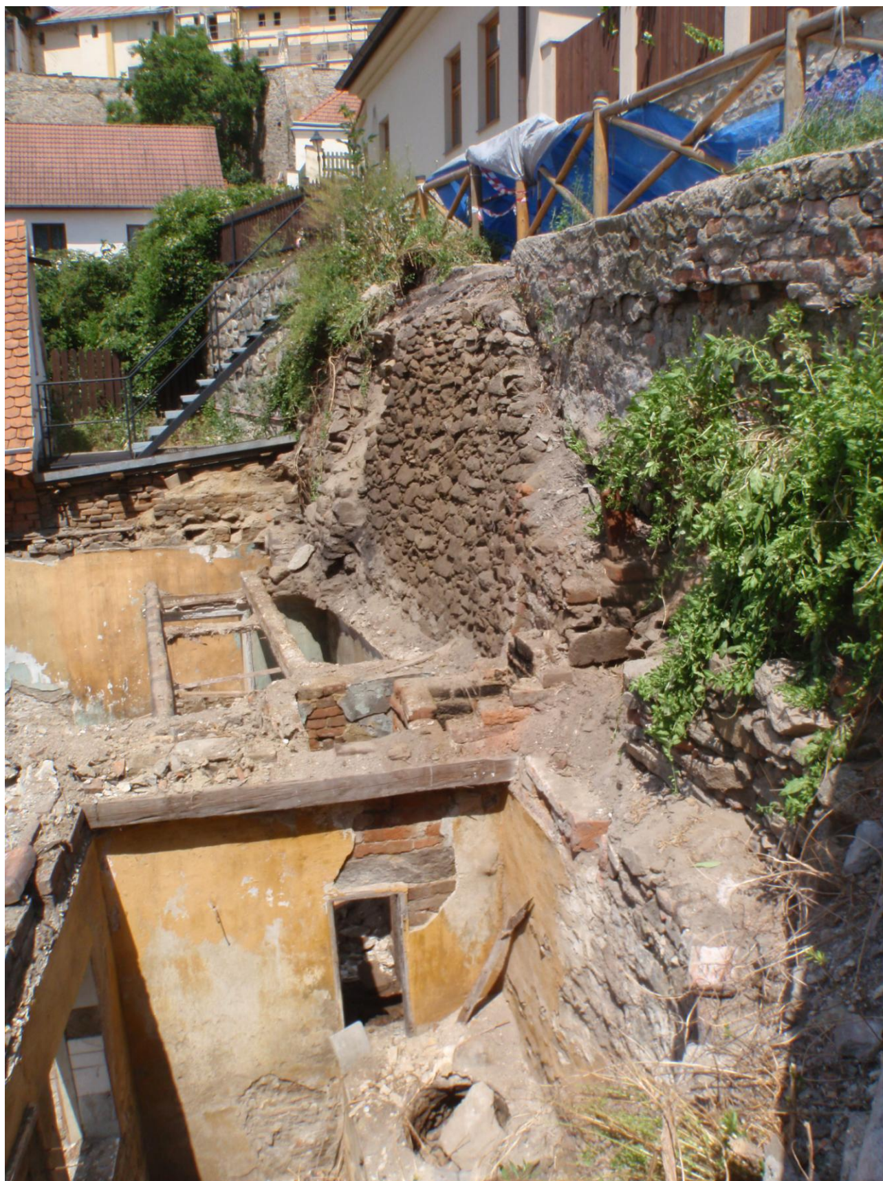
Pohled na opěrnou stěnu po odstranění střešních a stropních konstrukcí.
