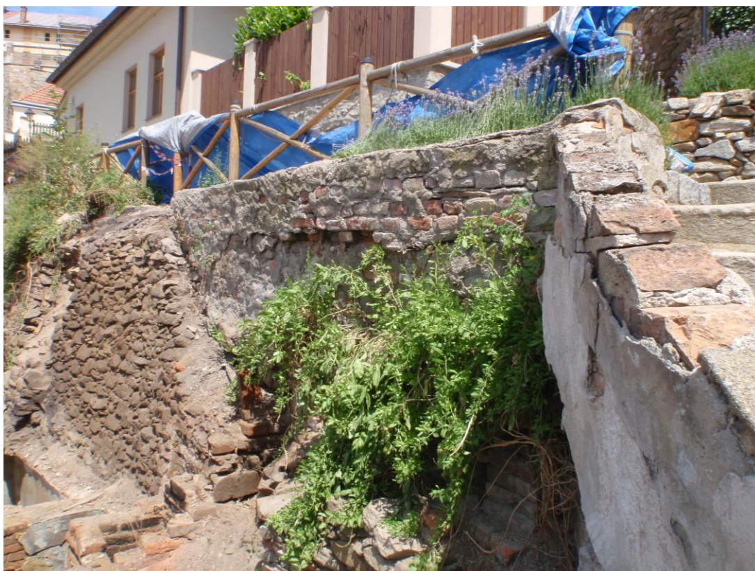
V pravé části pak kamenný plášť zcela absentuje a koruna zdi je odtržena.
