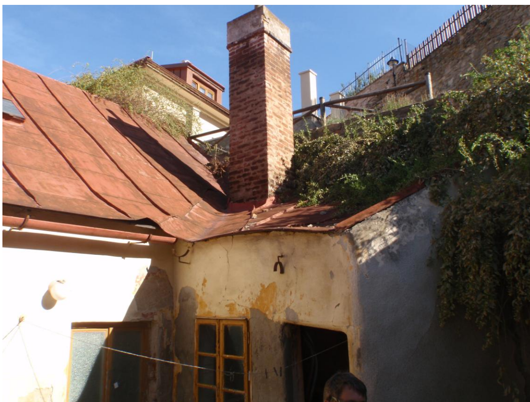
Opěrná stěna zde sloužila i jako štítová stěna přilehlého objektu – foto před odstraněním přilehlého RD..
