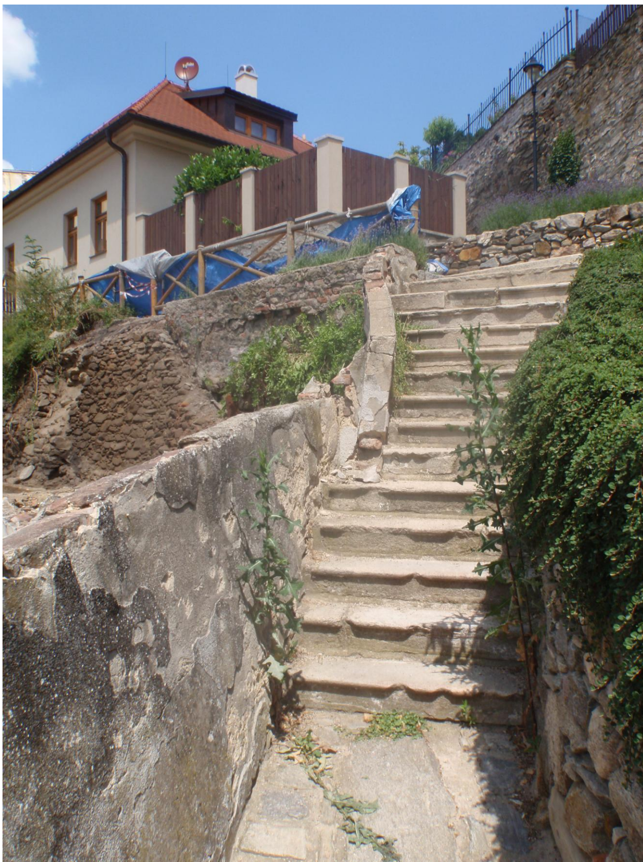
Vybočení ohradní stěny v místě terénního schodiště dosahuje rovněž kritických hodnot.
