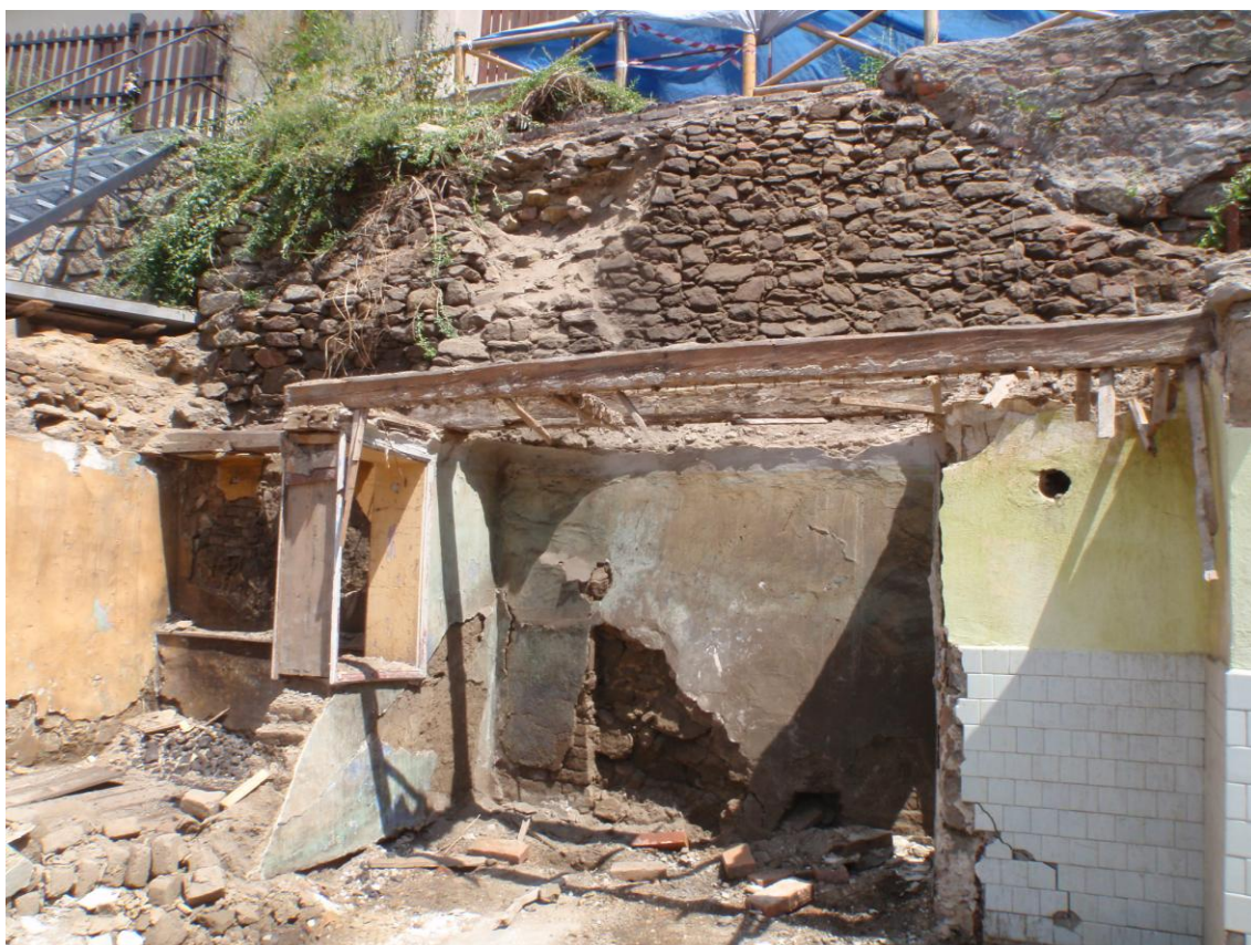
Dochází zde i k dílčímu rozpadu kamenného pláště stěny.
